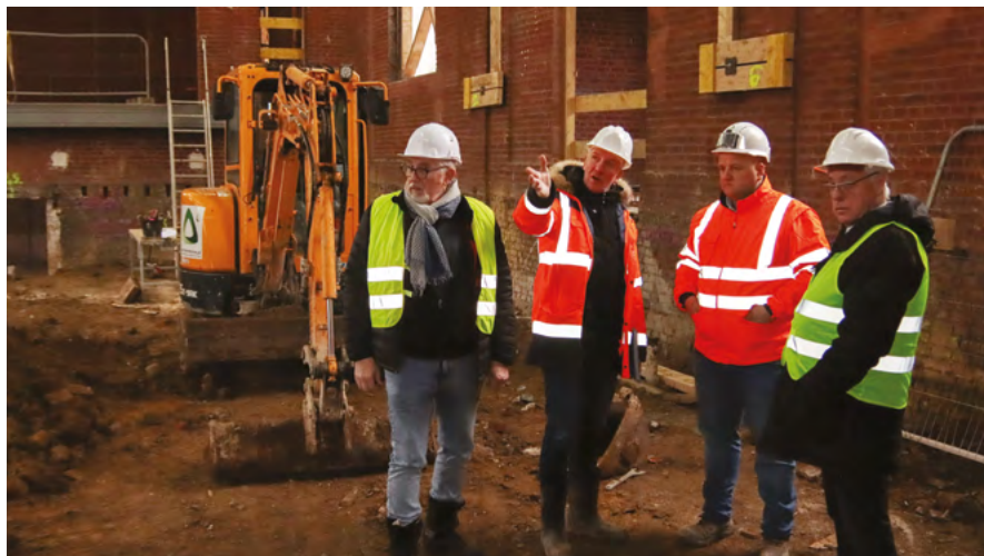
Réunion de chantier sur le site de la réhabilitation de la salle Daniel Carton à La Clarence
